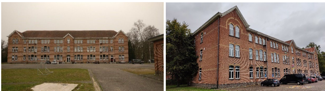
| Hoofdgebouw kwartier IJzer
